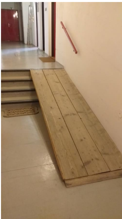
Obr. 3 Pohled na chodbu v 1.PP, nalevo od bezbariérového vstupu
