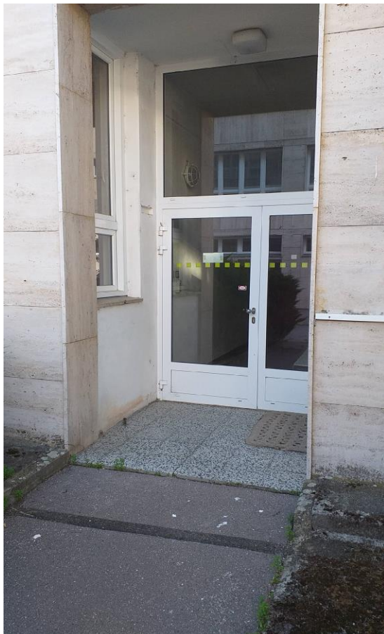
Obr. 1 Bezbariérový vstup z nádvoří v 1.PP budovy
