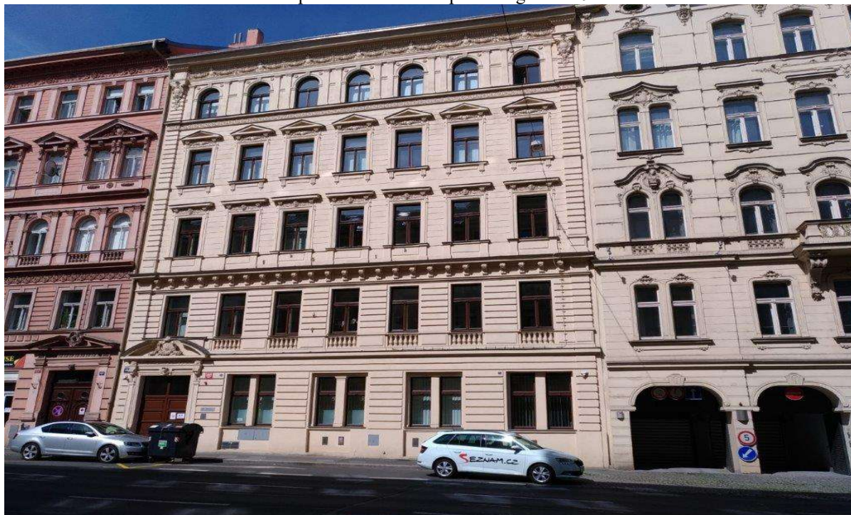
MSp - rekonstrukce a oprava Legerova 49
