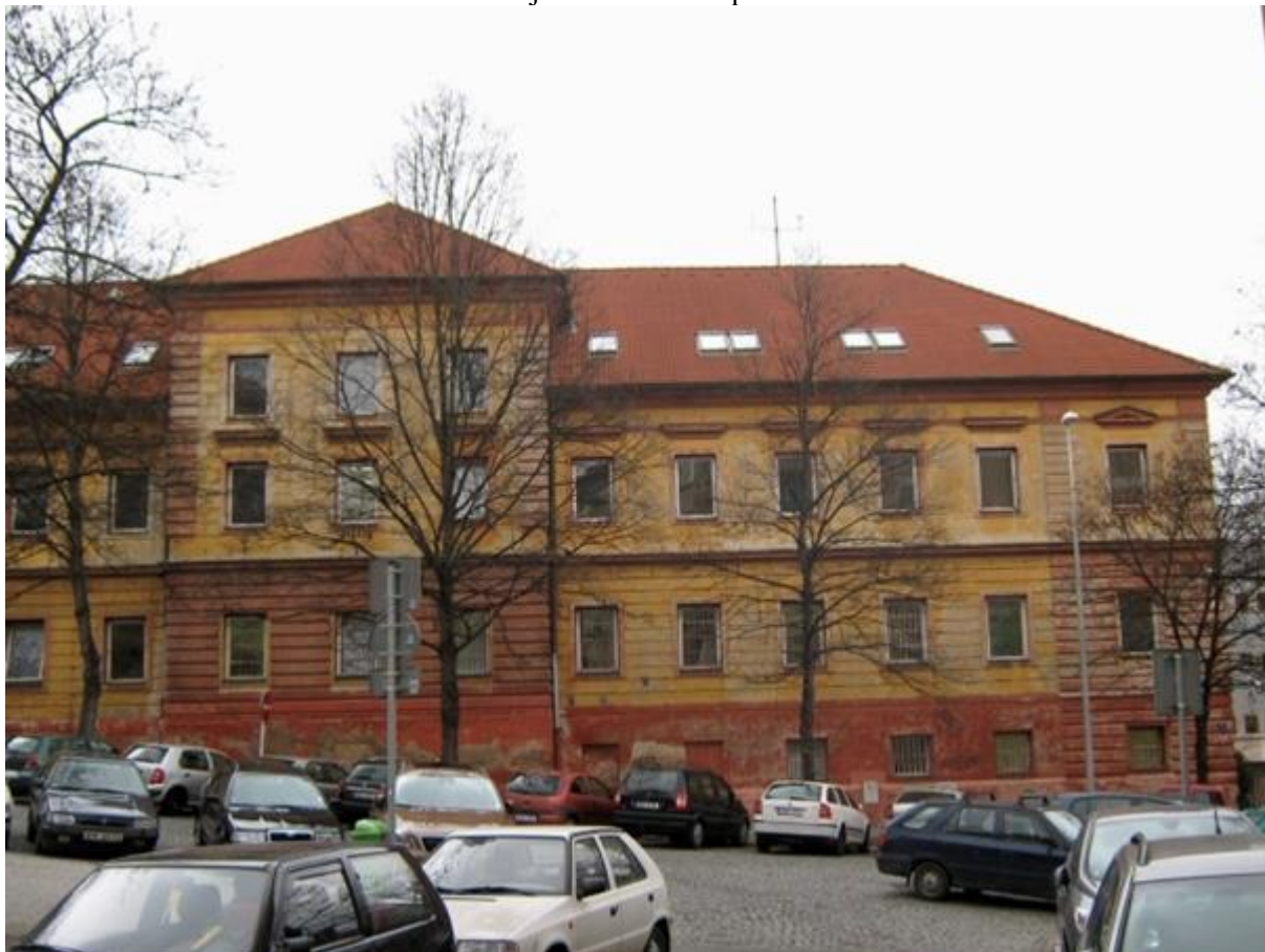
Rekonstrukce objektu CH – stav před rekonstrukcí:
