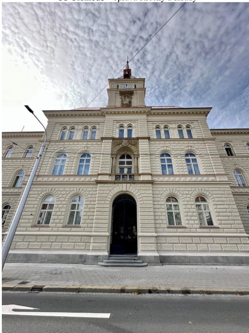
OS Olomouc – oprava střechy a fasády
