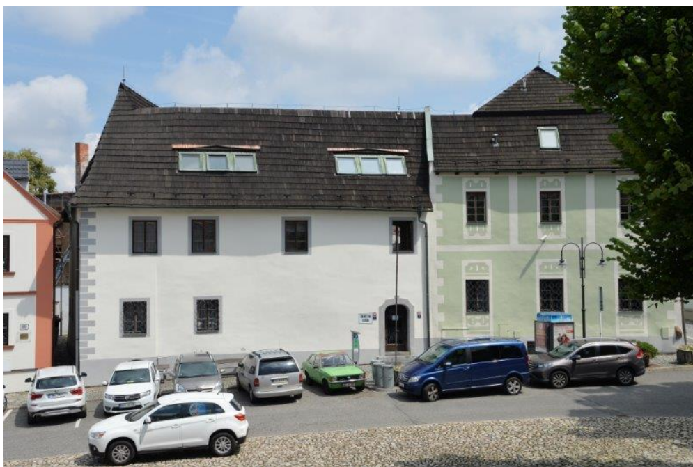
Budovy č. 38 a č. 39 – oddělení opatrovnické a exekuční
